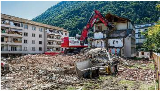
Die Überbauung Kasernenstrasse 133-139 wird derzeit abgerissen ...
